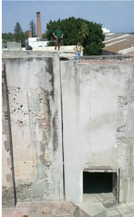
شکل ۳- مثالی از اثر درز سازه‌ای بر کنترل اثرات مخرب فرونشست غیریکنواخت [۲۲]
