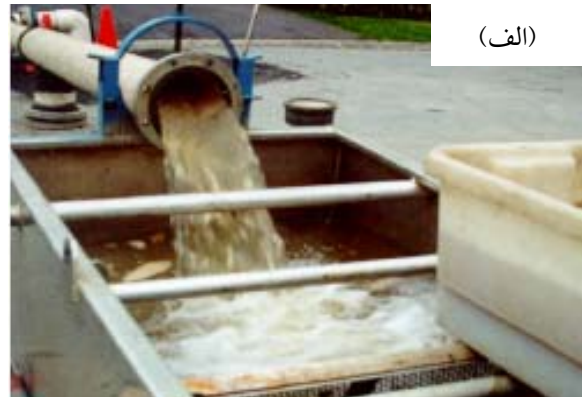
شکل (۸) - روش‌های پاکسازی لوله‌های انتقال مواد نفتی: (الف) روش Flushing (ب) روش Pigging
