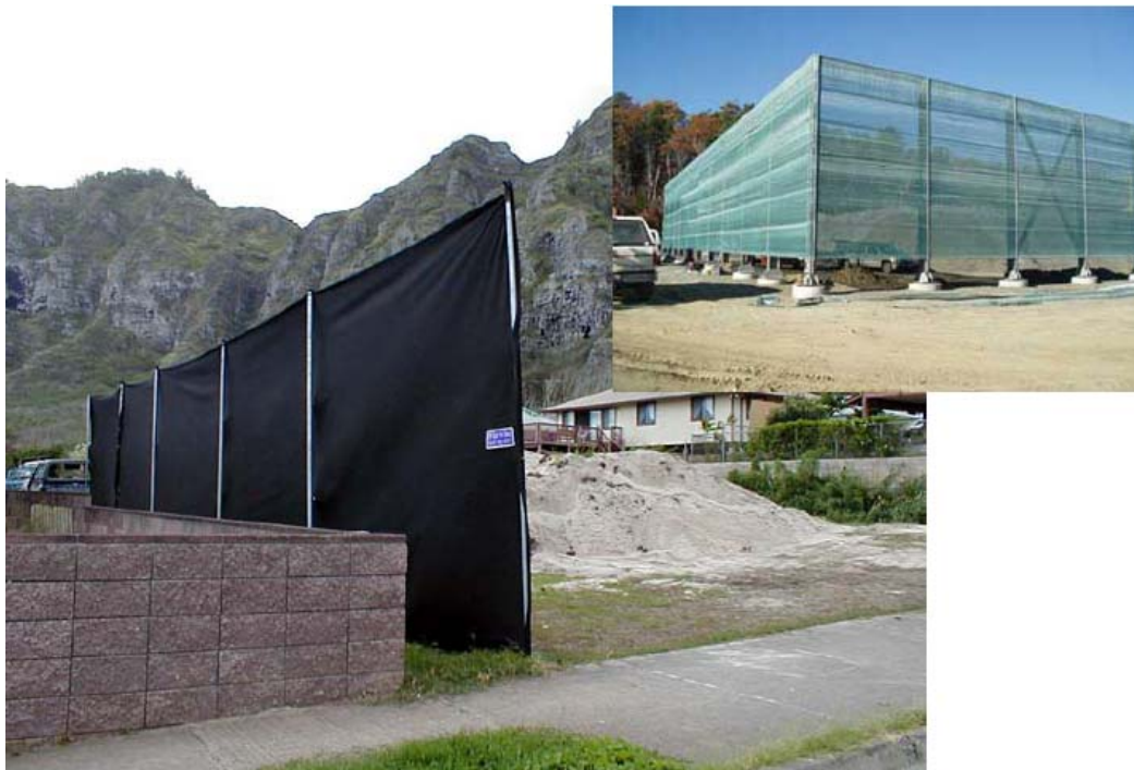
شکل ۵- استفاده از دیوارهای موقت جهت جلوگیری از انتشار گرد و غبار
