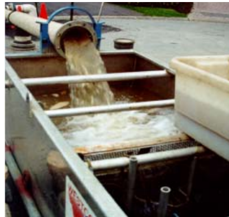
شکل ۱۱. شست‌وشوی لوله‌ها (Flushing)
