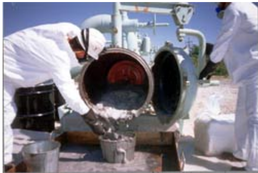
شکل ۱۲. پاکسازی لوله‌ها با Pigging
