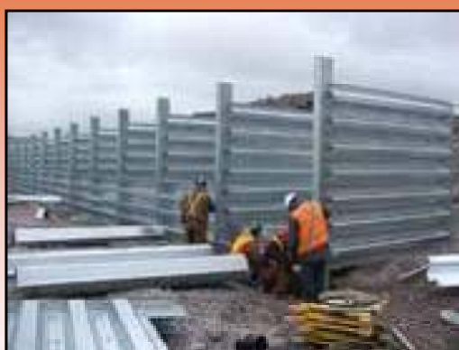
اجرای دیوار جعبه فولادی
