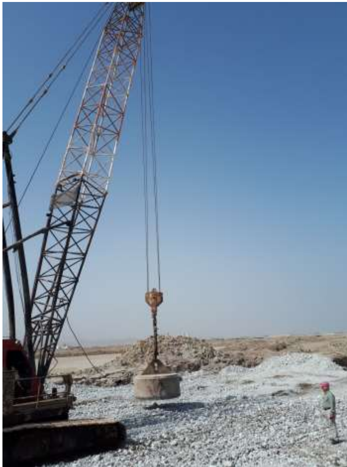
شکل ۴ - اجرای ستون شنی به روش تراکم دینامیکی در محل پروژه آب شیرین کن ساقی کوثر
