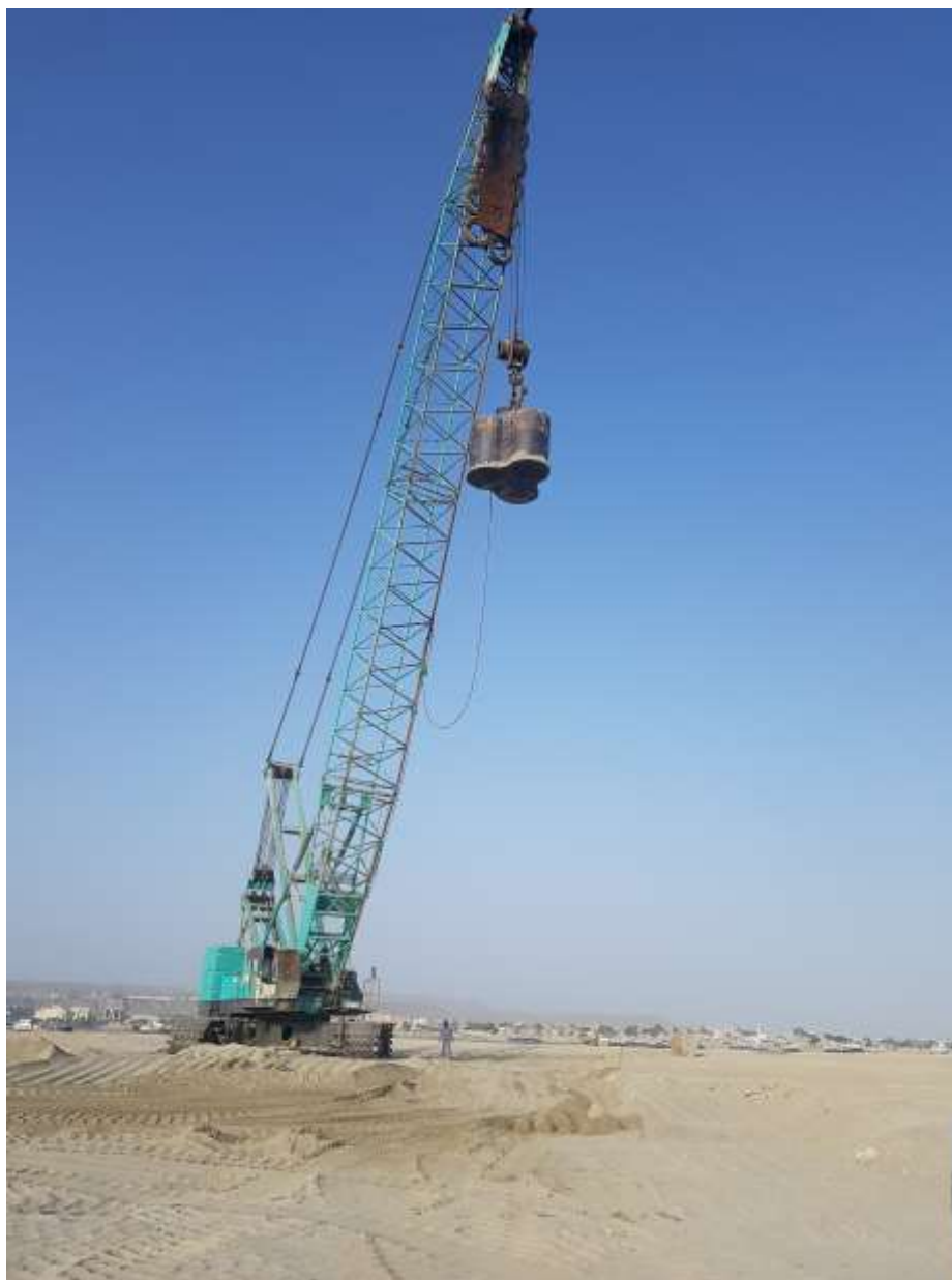
شکل ۵- اجرای ستون شنی به روش تراکم دینامیکی در محل بندر شهید بهشتی چابهار
